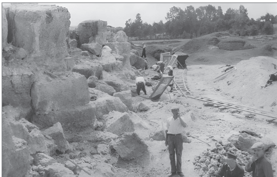
40. Eksploatacja kamienia gipsowego w Unikowie (Pankowe Doły), fot. J. Fijałkowski, około 1954 r. Źródło: MNKi/Pf/2756/127.
