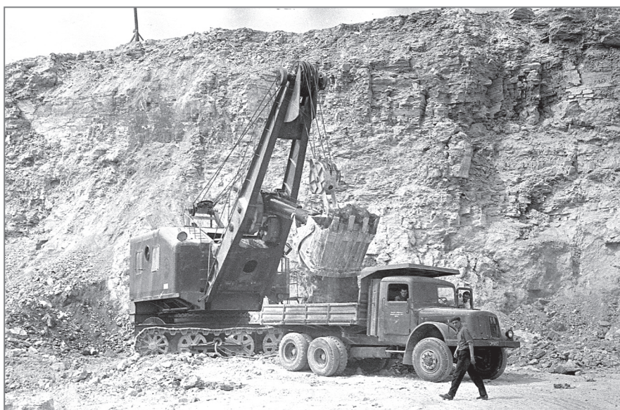
60. Eksploatacja prowadzona przez Zakłady Przemysłu Gipsowego „Dolina Nidy” w Gackach, na której widać ogromną skalę wydobycia i użycia środków, w porównaniu do ręcznych metod pozyskiwania surowca, jakie w tym samym okresie stosowały, opisywane w artykule Spółdzielnia Pracy „Kopaliny Mineralne” w Kielcach i Jędrzejowskie Zakłady Przemysłu Gipsowego. Nowa era nastała. Fot. Tadeusz Król, około 1962 r. Źródło: zbiory autora.
