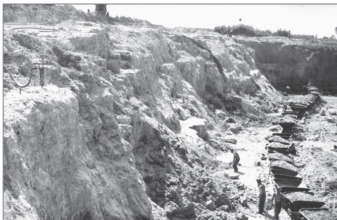
29. Gartatowice, prace w wyrobisku południowym Spółdzielni Pracy „Kopaliny Mineralne” w Kielcach (zob. il. 4 pkt 2c), 1975 r. Źródło: SPKM, Projekt techniczny jedno[etapowy] na rekultywację terenów pogórnich „Gartatowice” w Gartatowicach, [plansze, s. 2, fot. 1].
