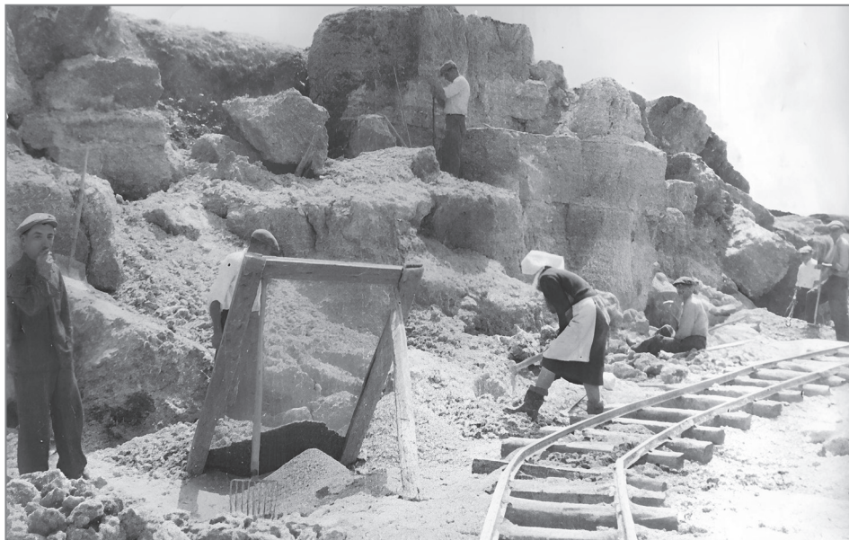
39. Eksploatacja kamienia gipsowego w Unikowie (Pankowe Doły), fot. J. Fijałkowski, około 1954 r. Źródło: MNKi/Pf/2756/129.
