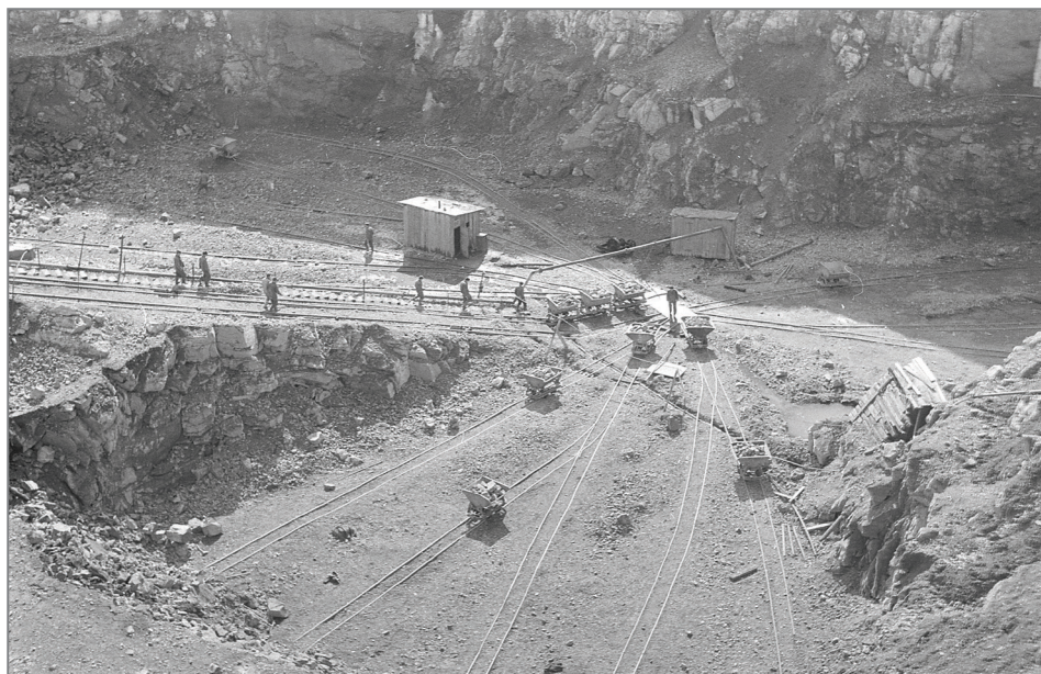
e – układ torowisk na najniższym poziomie wyrobiska zachodniego, fot. Z. Rubinowski, 1968 r.; źródło: zbiory autora.
