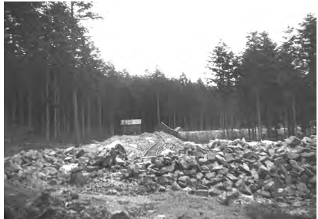
Ryc. 7. Góra Wierzejska, widok składowisk tłuczni od strony zachodniej, fot. J. Fijałkowski, 1960. MNKi/Pf/982
