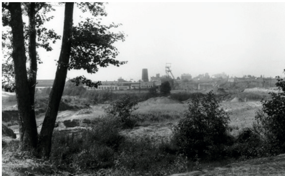
Il. 1. Panorama kopalni w Rudkach, widok od wschodu. W krajobrazie najbardziej zwraca uwagę stalowa konstrukcja wieży wyciągowej szybu „Stanisław” oraz wieża ciśnień, MNKi/Pf/1897, fot. J. Fijałkowski
