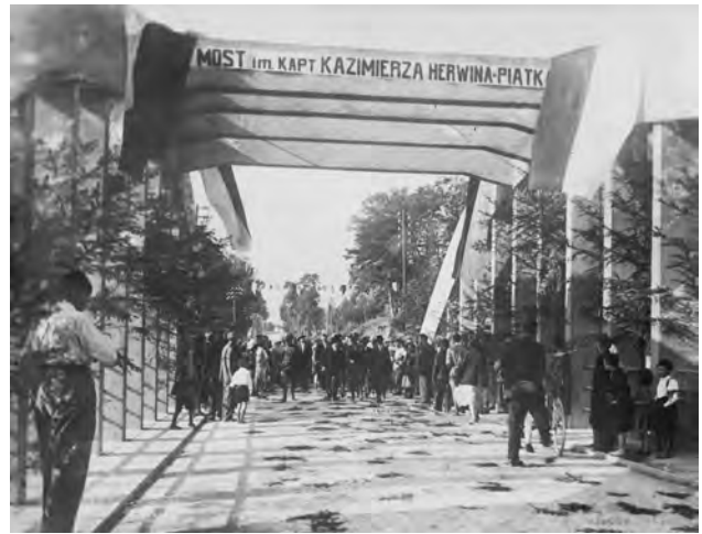
Ryc. 6. Fotografia wykonana prawdopodobnie w dn. 8 sierpnia 1931 r., w dniu uroczystości poświęcenia mostu na cześć kpt. Kazimierza „Herwina” Piątka, podpisana przez autora: „Most na Słowiku na rzece Bobrzy, dr. państw. nr 13 /trakt Kielce - Kraków/ zbudowany w 1930-1931 r.”, fot. Mieczysław Tuszyński z Kielc [urzędnik w referacie grobownictwa wojennego w Okręgowej Dyrekcji Robót Publicznych UW w Kielcach], ze zbiorów Tomasz Kalety z Zagnańska
