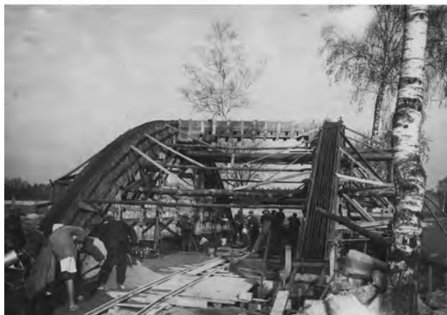
Ryc. 7. Budowa mostu łukowego na rzece Liswarcie (gm. Lisów, pow. lubliniecki) na trasie Częstochowa – Lubliniec, ukończonego w 1929 r. Źródło: Narodowe Archiwum Cyfrowe, sygn. 3/1/0/8/3304/1, 3/1/0/8/3304/2
