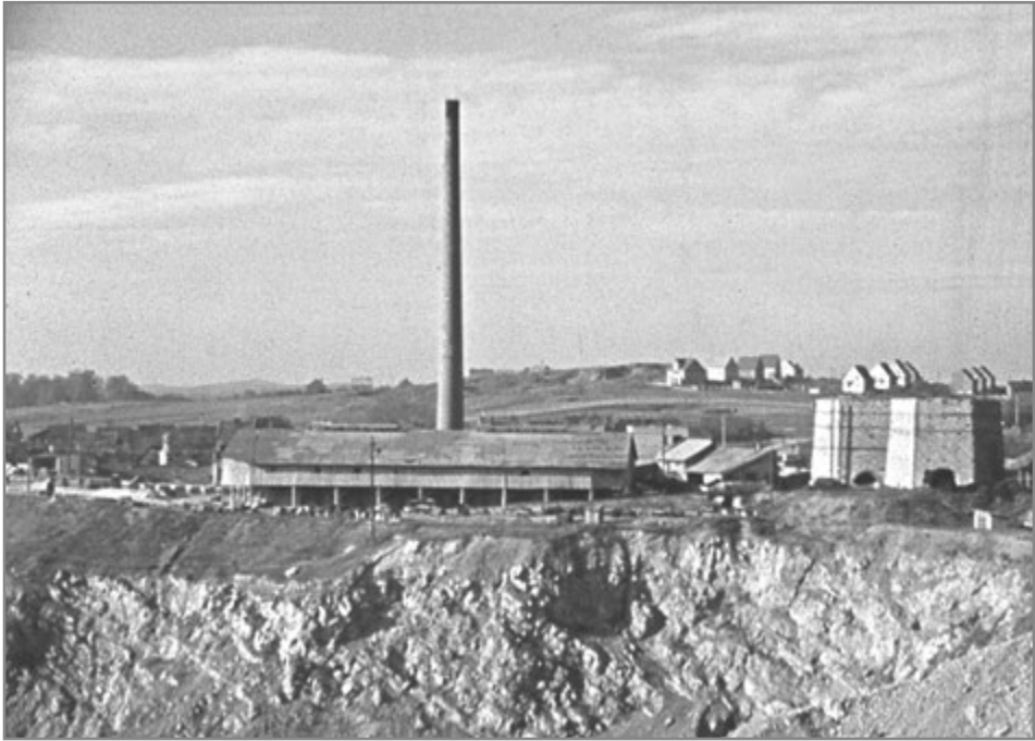
15. Fragment wyrobiska „Wietrznia” rodziny Zagajskich z wapiennikiem hoffmanowskim (na środku) i dwoma wapiennikami szybowymi z XIX w. (po prawej), fot. Z. Rubinowski, przed 1972 r. (lata sześćdziesiąte XX w.). Źródło: zbiory autora.
