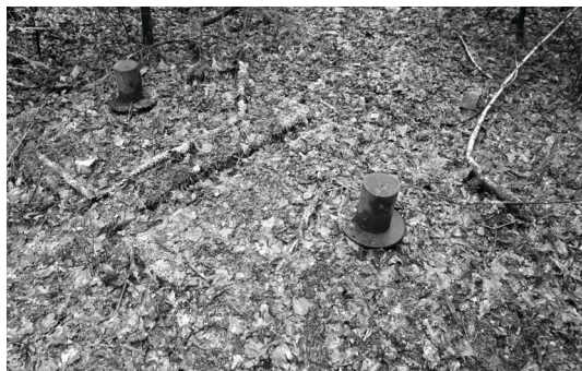
Il. 15. Dwa cokoły betonowe ze stalowymi osiami bębnow przekładni linowej funikularu z lat 1952–55, który funkcjonował podczas eksploatacji kamieniołomu „Byk”, uruchomionego na potrzeby produkcji kostki brukowej do budowy Pałacu Kultury i Nauki w Warszawie (wysokość stalowych osi 30 cm, średnica 15 cm), fot. P. Król, 2019 r.
